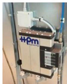
Gruppo di filtrazione ed essiccazione aria compressa ECONOMIZER installato a bordo cabina e collegato ad attacco rapido interno.
