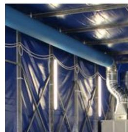
Climatizzazione della cabina con immissione aria attraverso canali microforati con tecnologia laser con possibilità di controllo di temperatura e umidità per i processi da effettuare a interno cabina.
