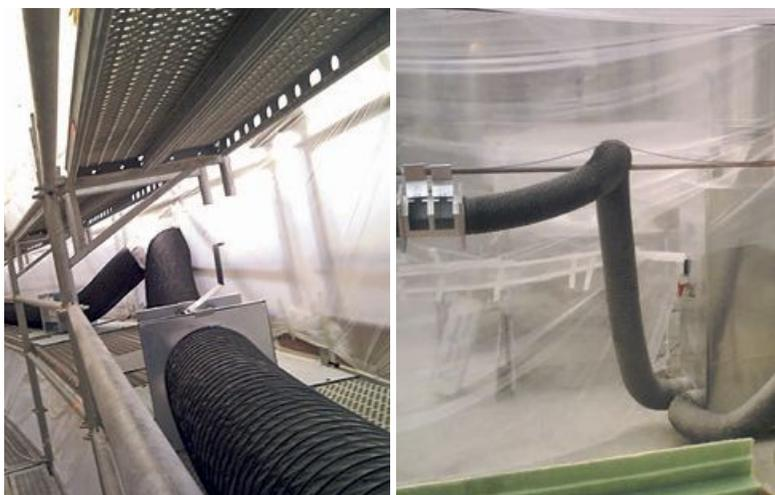
**1)** Realizzare un impianto di aspirazione e depurazione personalizzato in poco tempo, utilizzando semplici componenti modulari, facilmente posizionabili direttamente all'interno delle aree di lavoro senza dover costruire complicati sistemi fissi. Con questo stesso concetto il sistema può essere rapidamente smontato e trasportato al termine delle attività.
